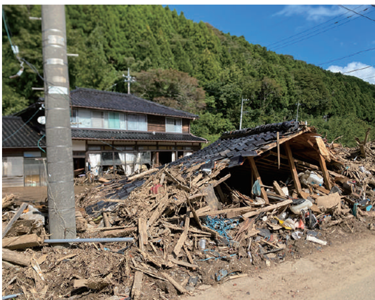
地震を耐え抜いた家屋にも土砂が流れ込み居住不可能に
